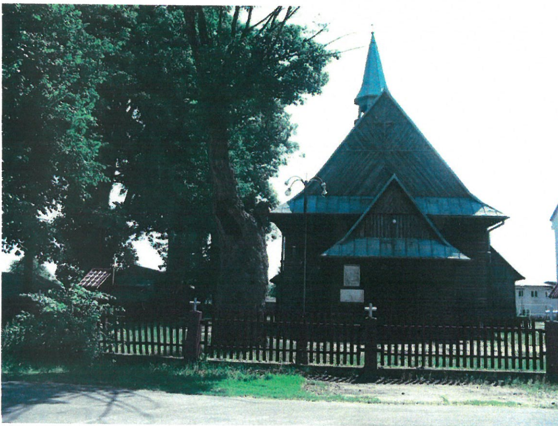
Widok od strony północnej
