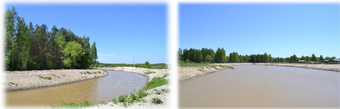
Prace przy zagospodarowaniu starego koryta rzeki Łęg przebiegają zgodnie z założonym harmonogramem
